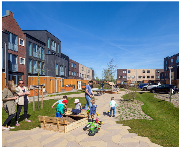
De woningen grenzen aan de achterzijde aan een collectief binnegebied dat functioneert als ontmoetingsplek voor omwonenden (bron: dezwartehond.nl/)
