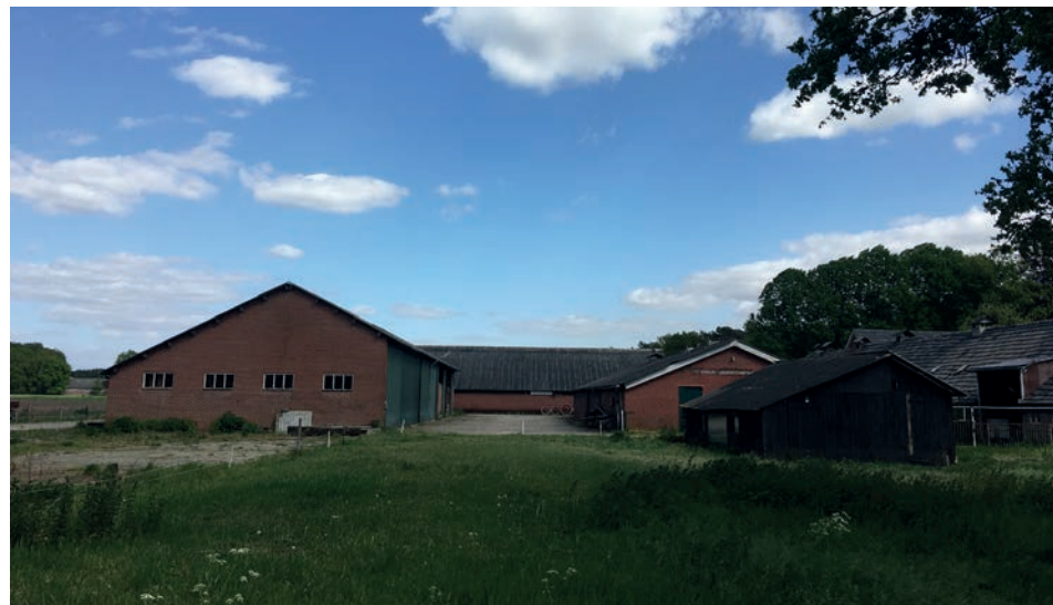
Afbeelding 5. Te slopen schuren
