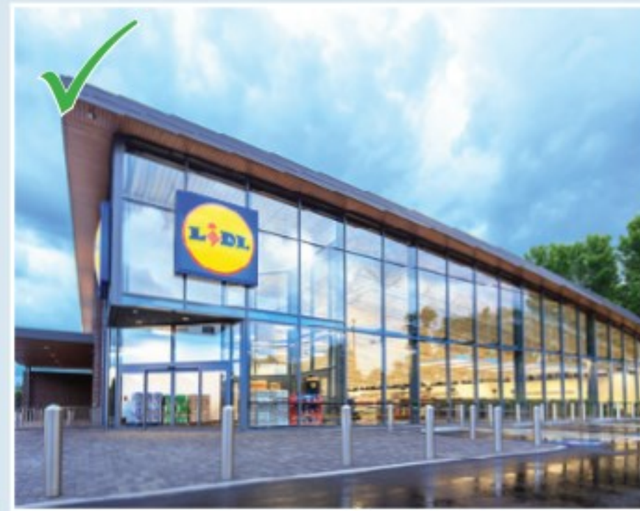
De gevel vertoont een duidelijke samenhang in uitstraling tussen de begane grond en de verdieping.
