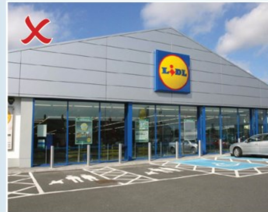
De gevel vertoont geen enkele samenhang in uitstraling tussen de begane grond en de verdieping.
