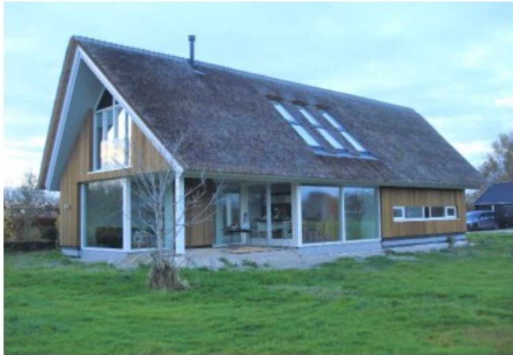
Empe, Maas Architecten
