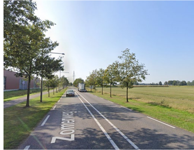
Huidige beeld aan de Zomerweg, aan weerszijden begeleid door een rij beuken. Rechts het plangebied van de Zomerweg gescheiden door een watergang
