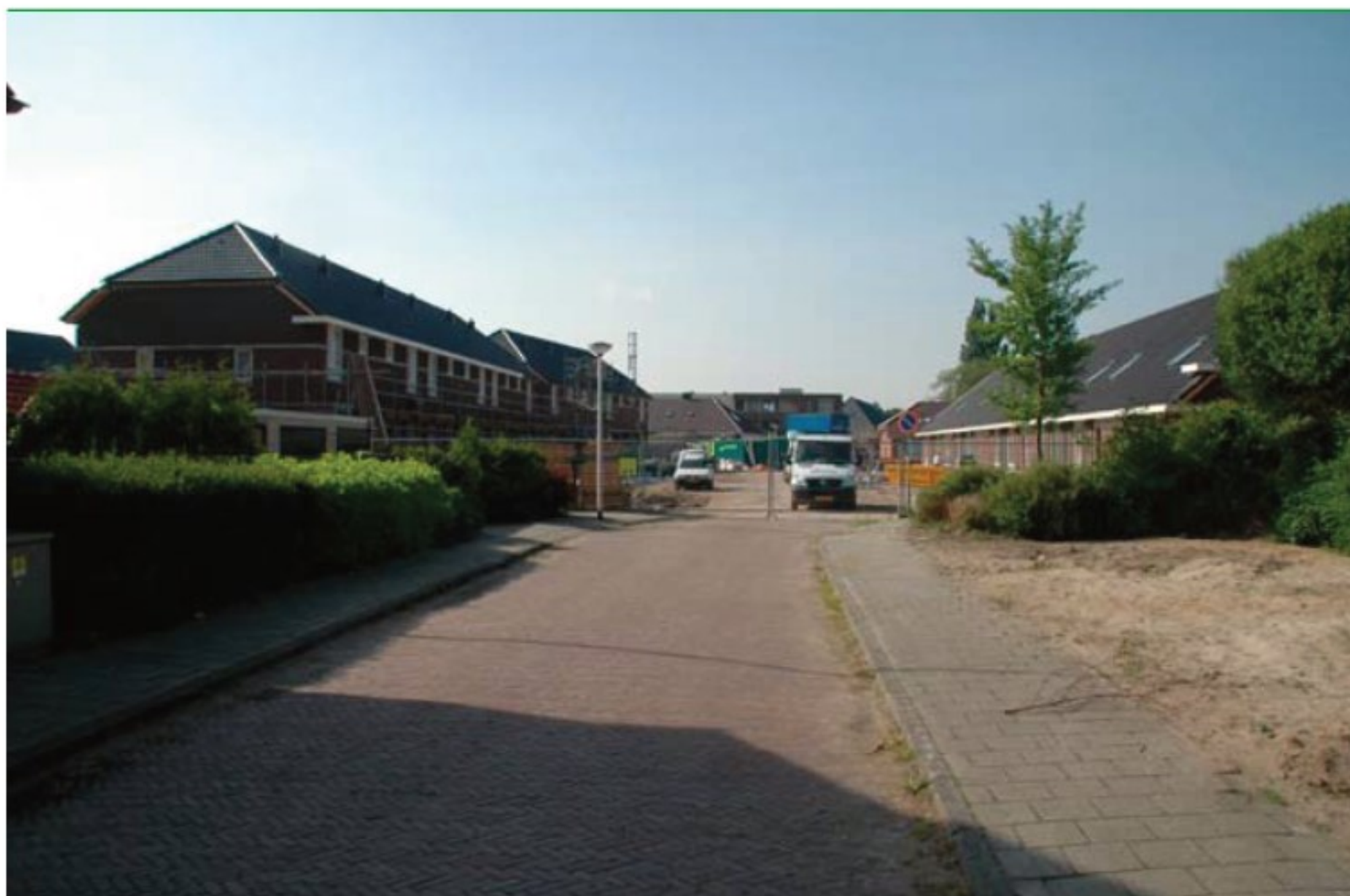
Nieuwbouw aan de W. van der Sluisstraat
