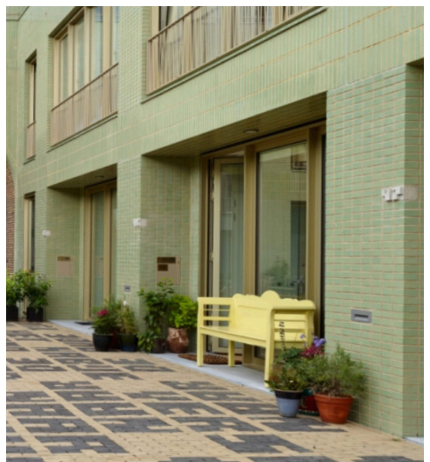
Buitenruimtes zoals balkons, dakterrassen en zitgelegenheden in de gevel zorgen voor een levendige relatie tussen bebouwing en het Stadspark (bron: marcellok.nl/)
