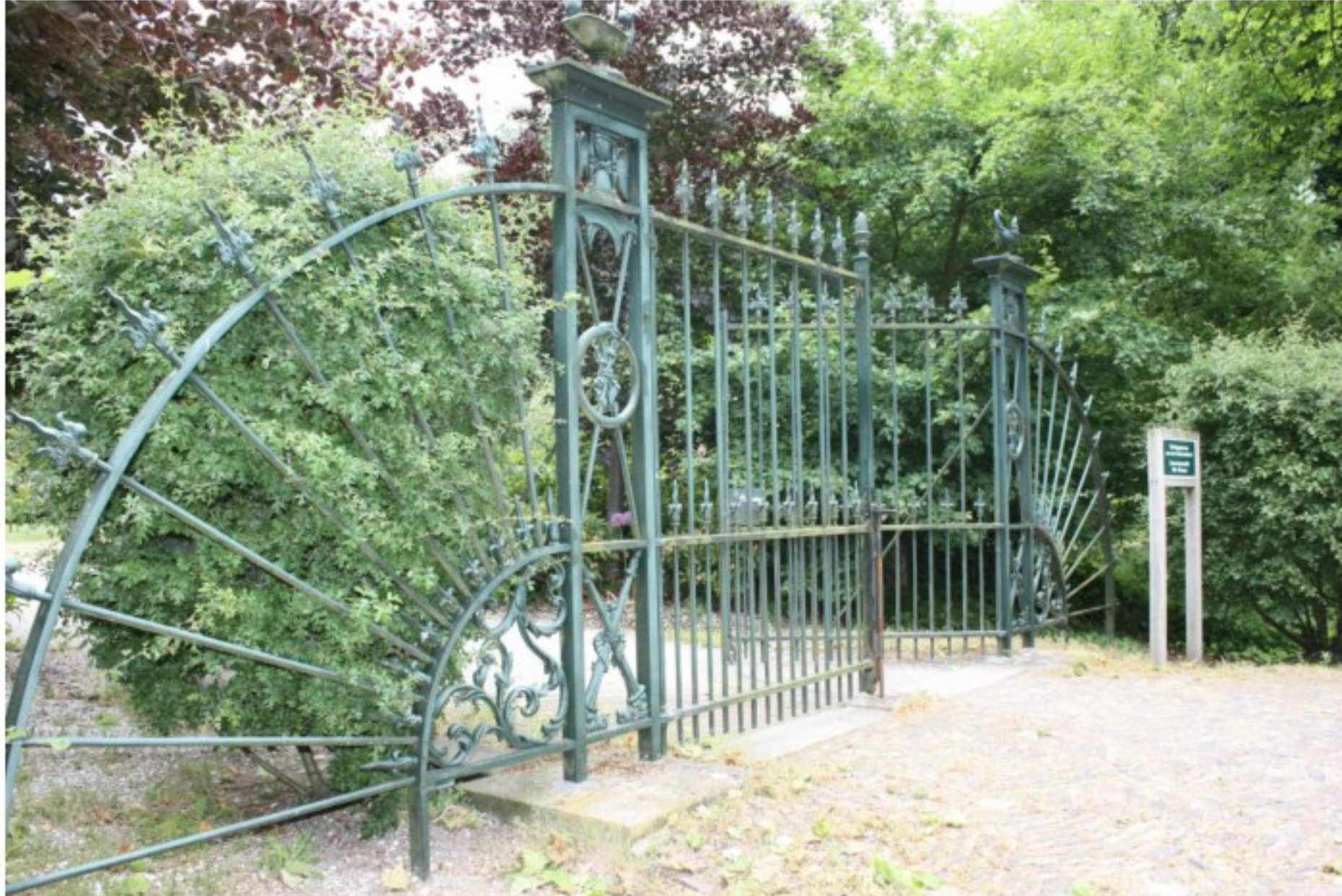
Het beschermde toegangshek
